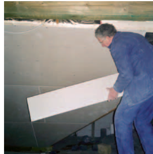
Hermann Budrat beim Ausbau des Dachgeschosses
